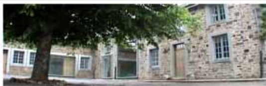
"Au dessus du Bie" Rue des Routis 27 Daoverdisse
