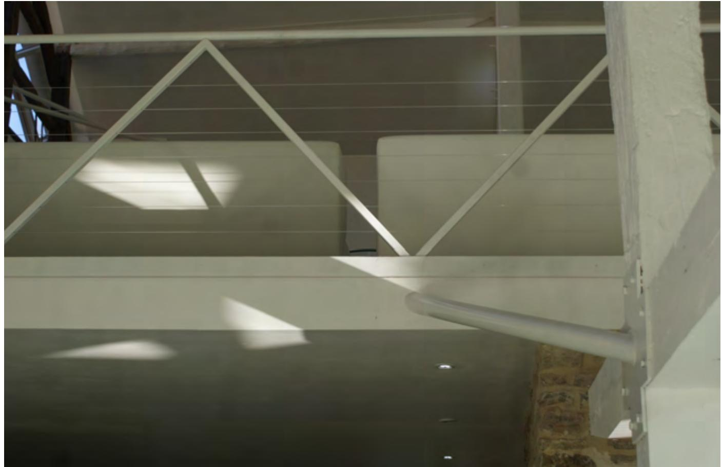
La toiture est soutenue par des pieux en bois instables de 9 mètres de haut. On les a reliés à la nouvelle dalle en béton qui les stabilise entièrement à un endroit crucial, c.-à-d. à hauteur des raccords. Aujourd’hui ces colonnes forment un ensemble inébranlable.
